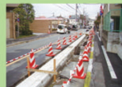
【写真⑨】整備工事開始
