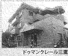
ドゥマンクレール三鷹
